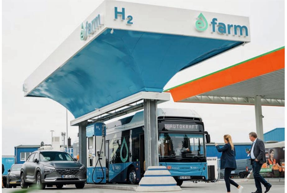
Das Projekt „eFarm“ von GP JOULE in Bosbüll (Kreis Nordfriesland) ist bereits realisiert: Überschussstrom aus Windkraftanlagen wird in grünen Wasserstoff umgewandelt, der dann getankt werden kann. Die anfallende Abwärme wird zudem in ein Nahwärmenetz eingespeist (li.).
