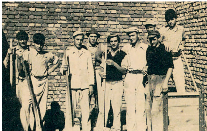
So fing alles an: Der junge Ignaz Walter (3.v.l.) als Maurerlehrling mit seinen jungen Kollegen auf einer Augsburger Baustelle.
