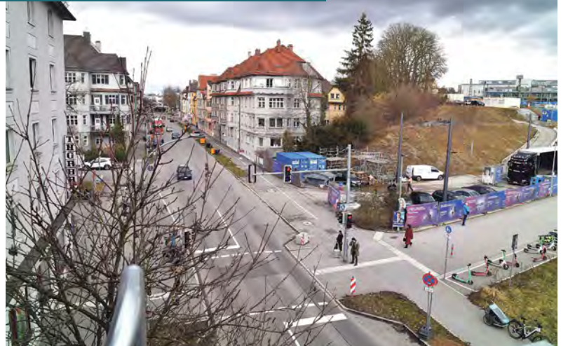
Die Stadtwerke Augsburg (swa) und die Stadt Augsburg beginnen ab März mit dem Großbauprojekt „Lückenschluss PLUS“ in der Rosenaustraße. Ab Mai beginnt der Gleis- und Straßenbau zwischen Sebastian-Buchegger-Platz und Pferseer Kreuzung.
