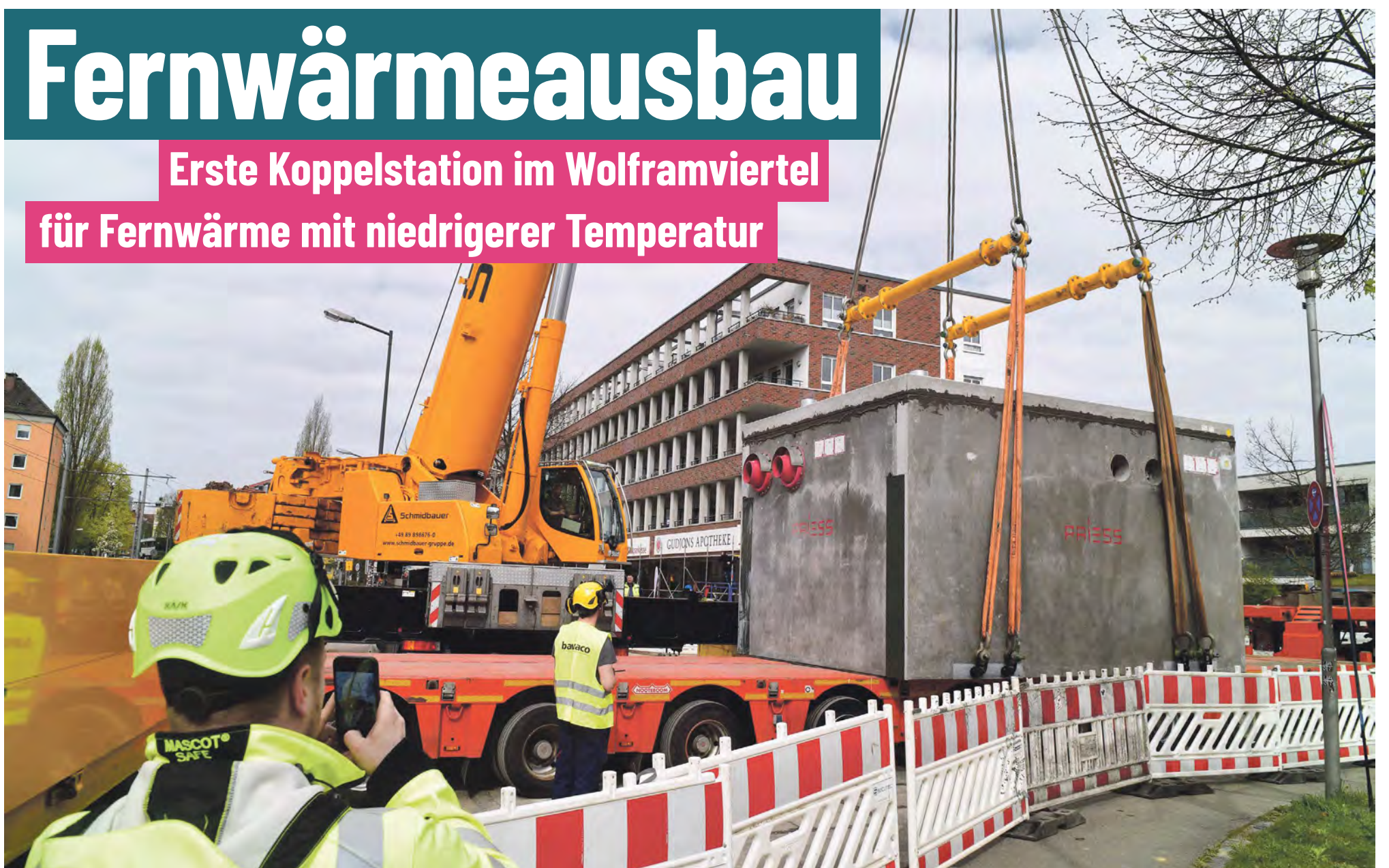
Die swa bauen in der Prinzstraße die erste Fernwärme-Koppelstation in Augsburg. Sie reguliert die Wärmtemperatur und ermöglicht das Einspeisen von Wärme aus erneuerbaren Quellen. Fotos: swa/Thomas Hosemann
